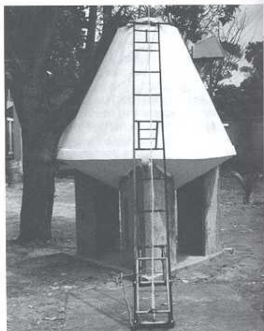
Bild 2: Luftdichter Lagerbehälter aus Ferrozement für Reis in Sri Lanka.
